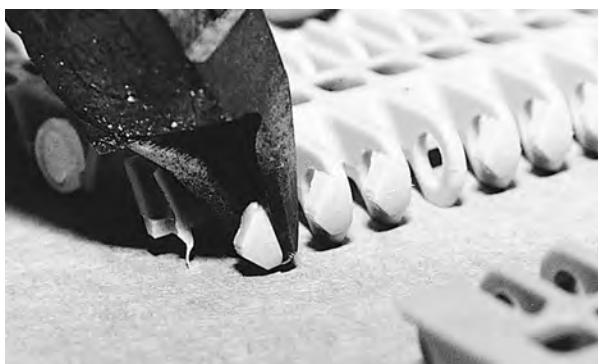
Figur 27: Kutt spissen av avstandsholderen
